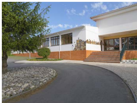
ALBERGARIA-A-VELHA Incubadora de Empresas do Município de Albergaria-a-Velha
